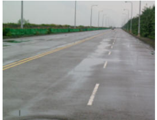
雨天時局部的積水路面，可能造成車輛單側水漂之危險性常被忽視！請提前減速慢行！
